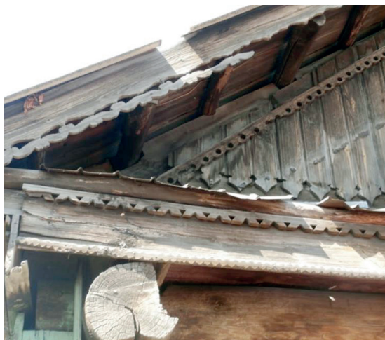
Угол фронтона дома (ул. Шаховская, 37)
